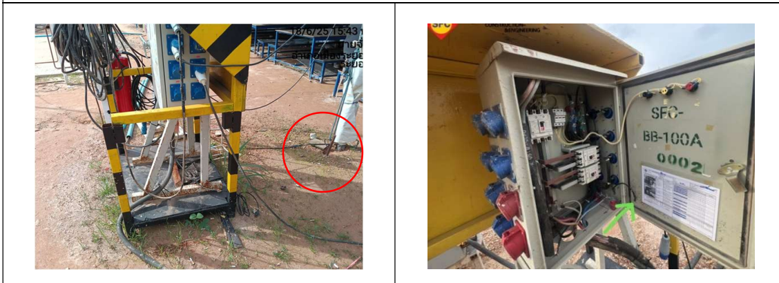
รูปที่ 31 ติดตั้งสายดิน บริเวณเครื่องจักรที่ใช้ไฟฟ้า
