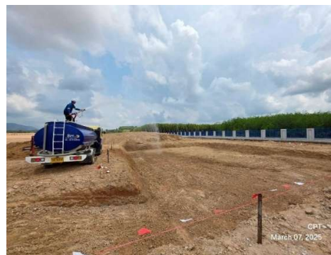
รูปที่ 1 การฉีดพรมน้ำบริเวณพื้นที่ก่อสร้าง
