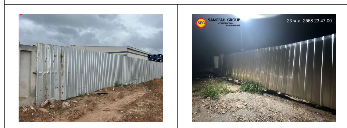
รูปที่ 5 การสร้างรั้วชั่วคราวหรือแผงกั้นฝุ่น โดยรอบพื้นที่ก่อสร้าง
