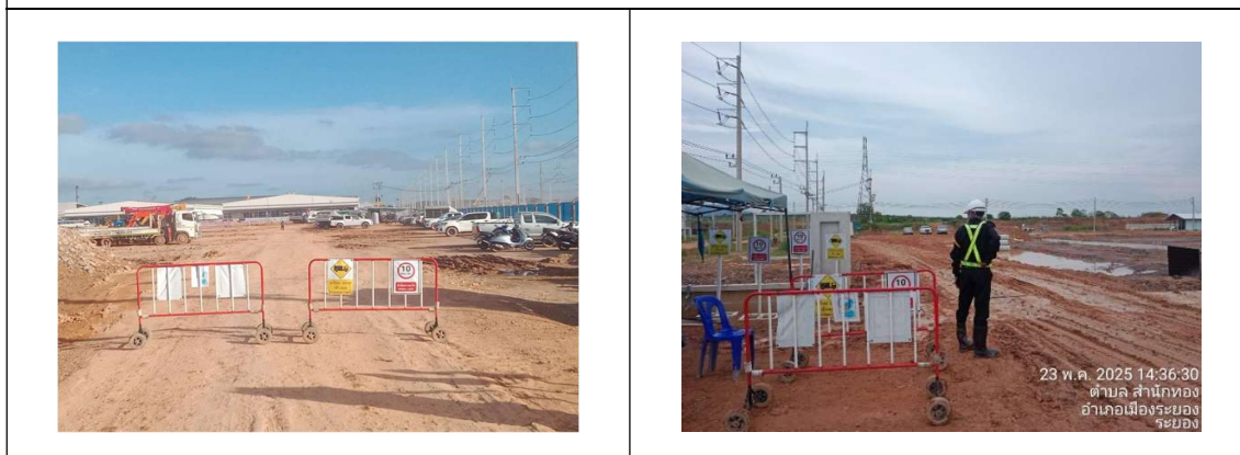
รูปที่ 13 การจัดระบบทิศทางการจราจรในพื้นที่ก่อสร้าง พร้อมจัดเจ้าหน้าที่คอยดูแลสถานที่เข้า-ออกพื้นที่ก่อสร้าง
