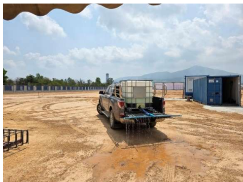
รูปที่ 1 การฉีดพรมน้ำบริเวณพื้นที่ก่อสร้าง
